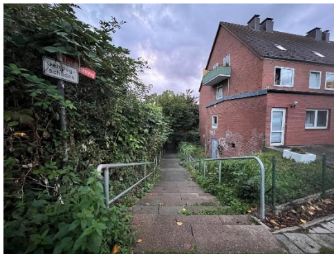
Fehlende Beleuchtung & Gehwegschäden – Neumühlen -Dietrichsdorf
